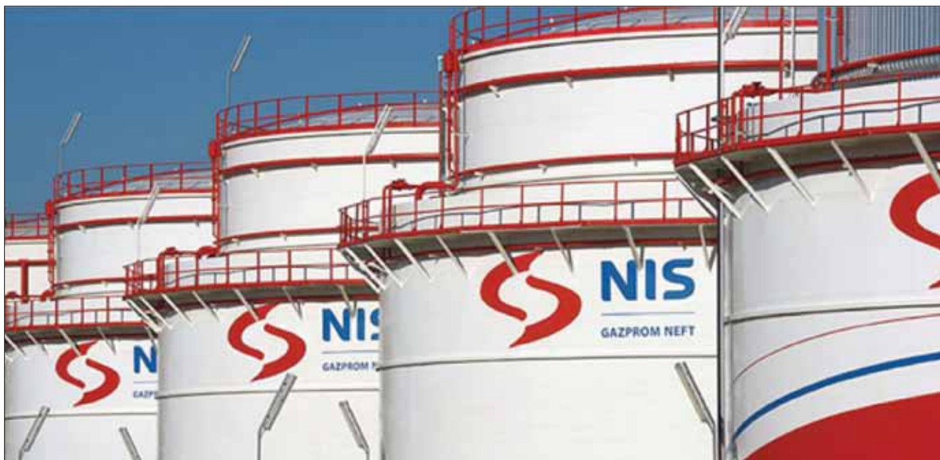
Фото 1. Резервуари NIS — дочірньої компанії «Газпромнефти»
